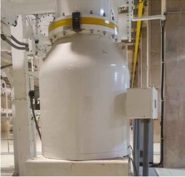
Figura 4. Transformador de potencial na UHJ.
