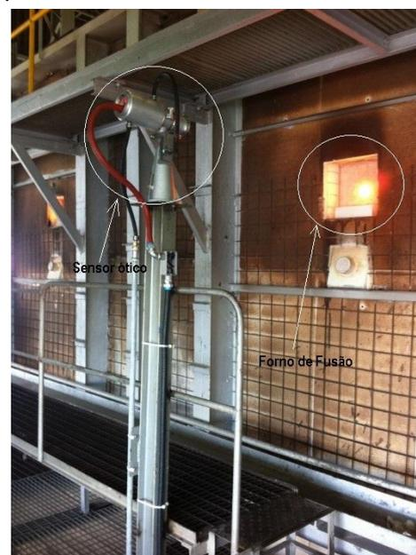
Figura 2. Sensor ótico instalado em um forno de fusão de vidro.
