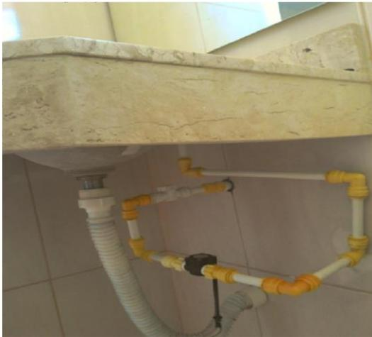
Figura 5. Detalhes da instalação do medidor no lavatório.
