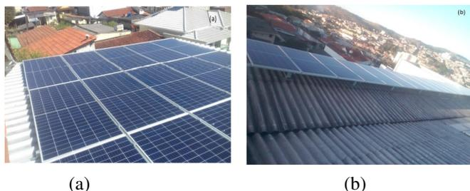
Fig. 6 Sistemas Fotovoltaicos (a) com estruturas fixas no telhado - Gerador A; (b) com estruturas espaçadas e sobre o telhado - Gerador B.
