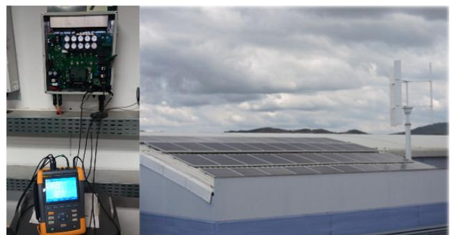
Figura 4. Medição no ponto de acoplamento (esquerda) e painéis instalados no campus (direita)
