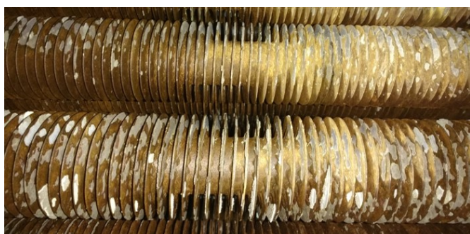
Fig. 5: Tubos aletados após a limpeza.
