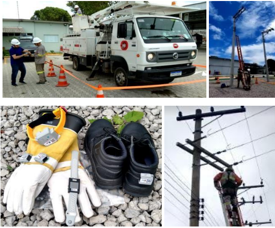
Fig. 8. Testes: Em duas distribuidoras de energia elétrica.
