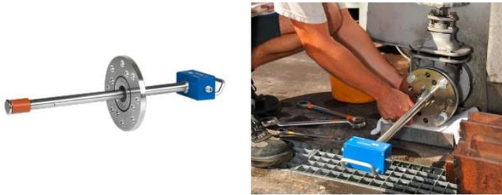
Fig. 3: Sensor UHF comercial instalado no dreno do transformador a óleo.
